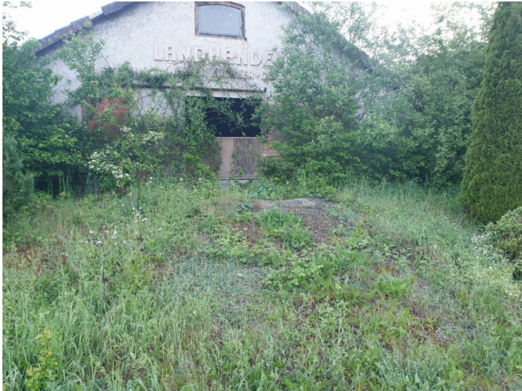
Abb. A3: ehemaliges Lagerhaus
